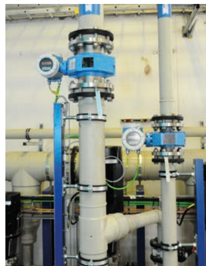
Over alt på afsaltningsanlægget på Amagerværket sidder målere fra Endress+Hauser, som sørger for at overvåge alle de kritiske parametre for vandkvaliteten, heriblandt tryk, temperatur, flow, niveau, pH-værdi og ledningsevne.
