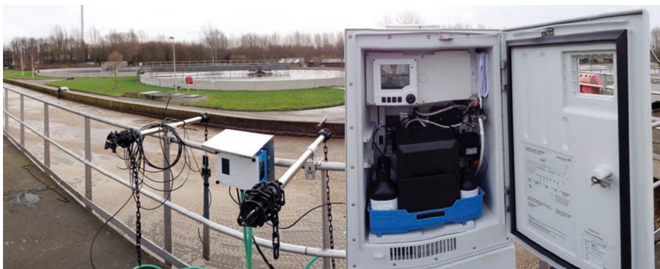
Analysatoren CA80 overvåger indkommende C/N/P-forhold, som giver dig et detaljeret overblik over processen og evnen til hurtigt at håndtere belastningstoppe eller afbrydelser.
