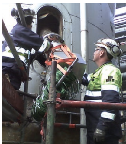
Octoplus Multipoint installeres af lokale entreprenører under tilsyn af ingeniører fra Endress+Hauser.
