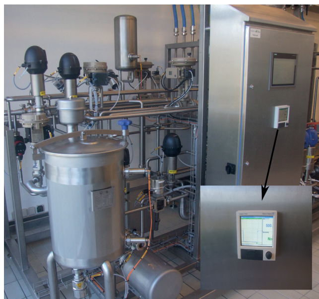
Pasteuriseringsprocessen kan overvåges via en lille fiks datamanager, Ecograph T RSG35.
