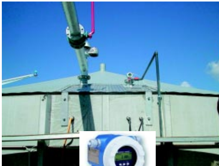
Niveaumåling med radar på en gylletank.
