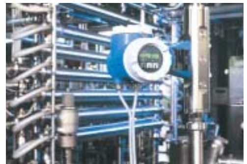
▲ Brix måling er almindelig måling ved fremstilling af læskedrikke - en Coriolis masseflowmåler kan kontinuerligt udlæse sukkerindholdet omsat til oBrix.
