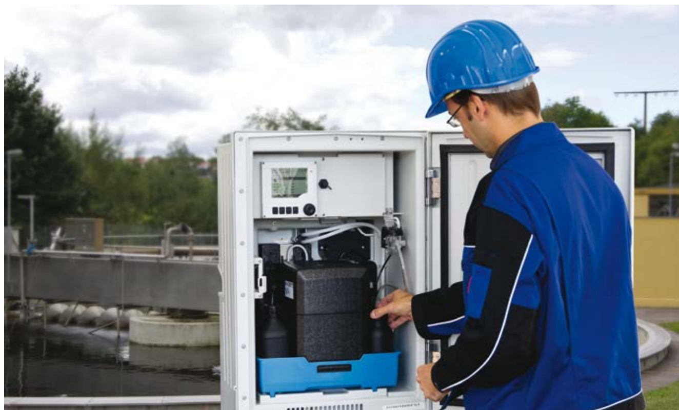
Den nye analysator CA80 er monteret i kabinet
