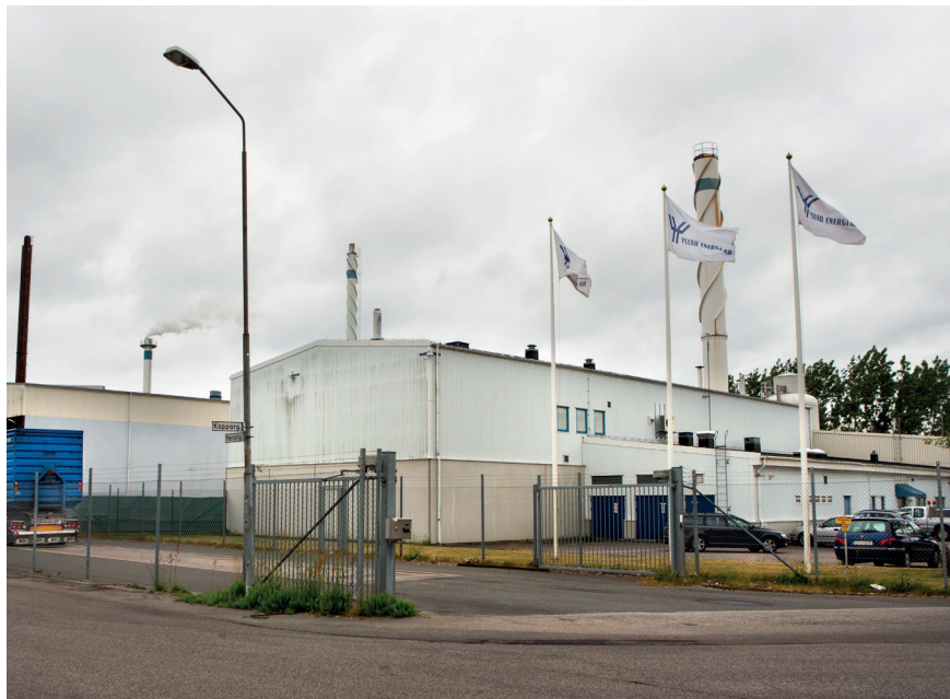
Ved hjælp af et radiometrisk målesystem fra Endress+Hauser kan Ystad Energi kontrollere og styre brændselsniveauet i sine fjernvarme kedler. Dette er en god løsning både miljømæssigt og økonomisk.
