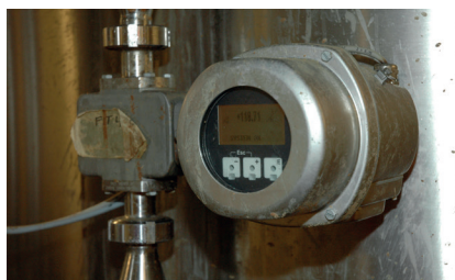
For at måle/overvåge dosering af melasse i foderproduktionen anvendes den elektromagnetiske flowmåler Promag 55H.
