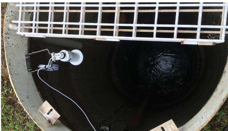
Testen af radaren FMR20 blev foretaget i en lidt vanskelig applikation i en brønd, hvor der modtages spildevand fra to industrier.
