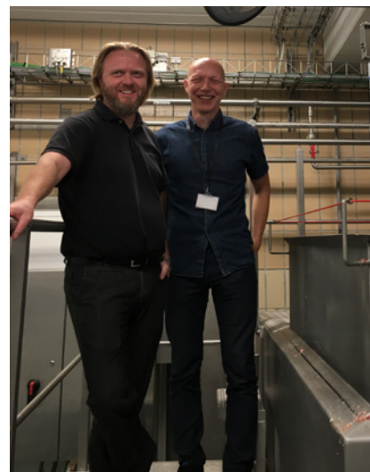
Automation Engineer hos ZPD A/S, Uffe Henneberg, fremviser her den installerede Micropilot FMR10 til salgssingeniør Rune Gressmann fra Endress+Hauser.
