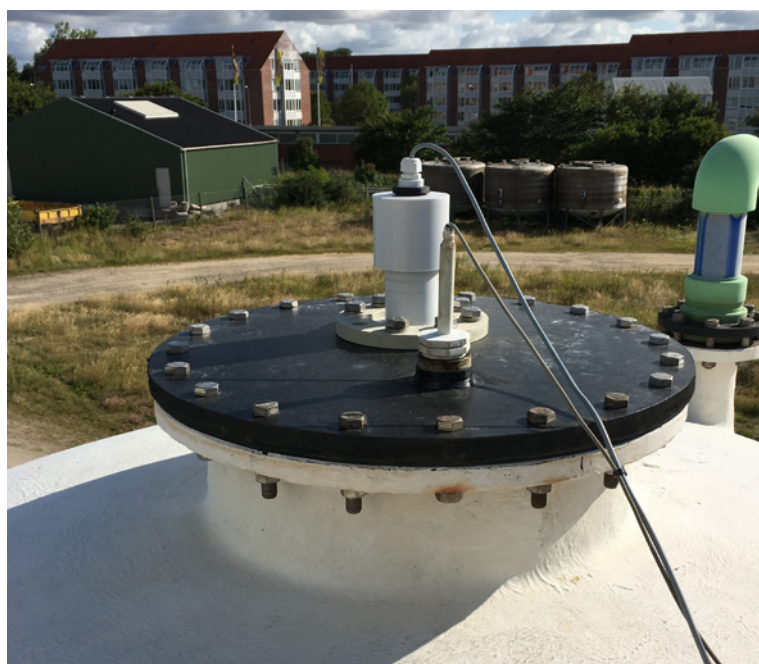
Udsigten fra toppen af tanken er fin, men med Bluetooth kommunikation slipper man for at kravle helt derop.
