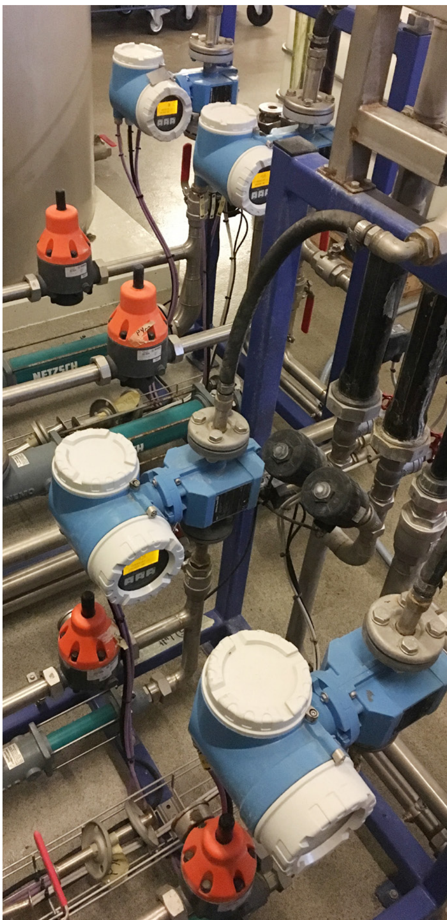
En typisk opgave som Krüger og Endress+Hauser har udført sammen; magnetiske flowmålere i et polymeranlæg.
