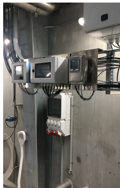
Til pH-målingen har AKV Langholt valgt Memosens teknologi fra Endress+Hauser.
