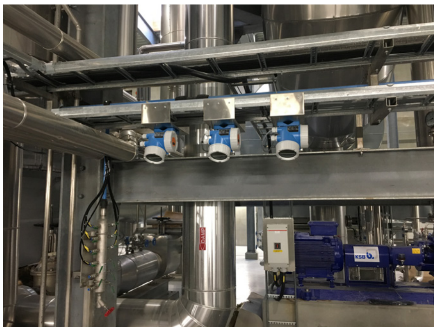
Da selve sensoren er placeret svært tilgængeligt, har AKV Langholt valgt Prowirl F 200 målere med separat sensor og elektronik.
