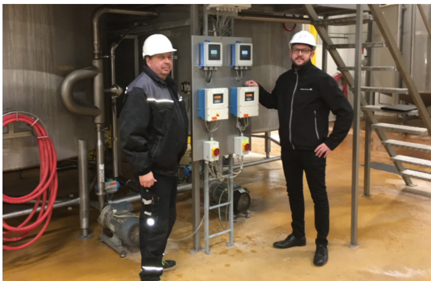
Vedligeholdstekniker ved AKV Langholt, Bo Oldenburg (til venstre), fremviser her de installerede Promass Q til salgssingeniør Thomas Andersen fra Endress+Hauser.
