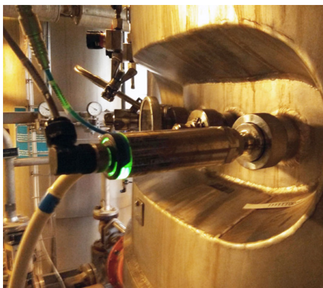
iTHERM TrustSens med placering på en fermenter.
