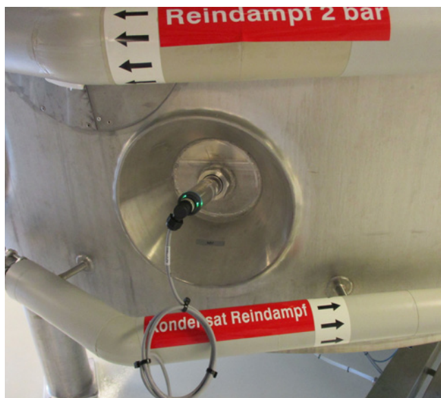
iTHERM TrustSens med placering på en buffertank.
