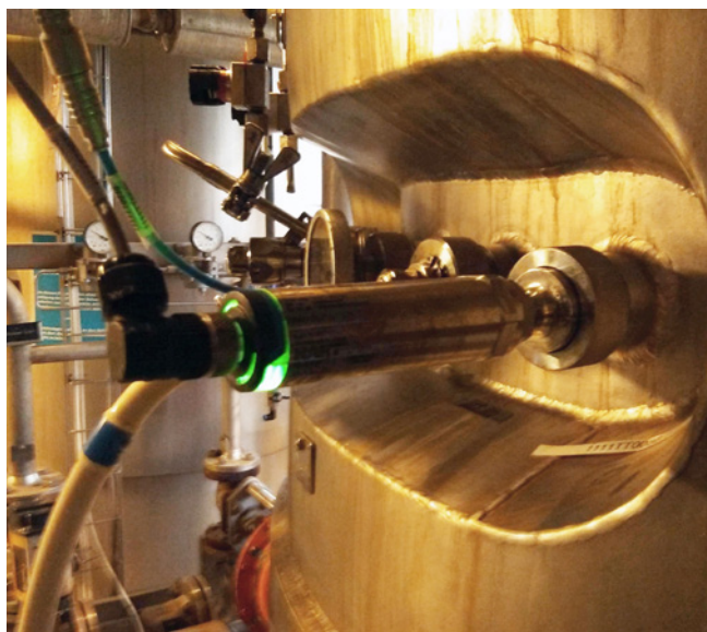
iTHERM TrustSens med placering på en fermenter.
