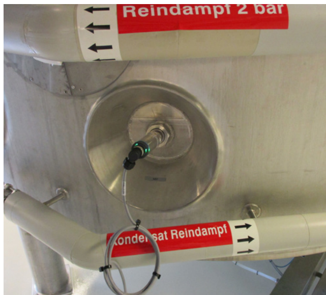
iTHERM TrustSens med placering på en buffertank.
