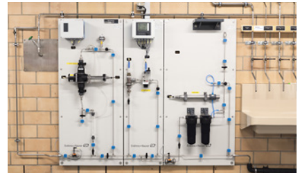
Vandtilsynsføreren på Frasnacht-rensningsanlægget, Rolf Bügler, er yderst tilfreds med analysepanelet fra Endress+Hauser.
