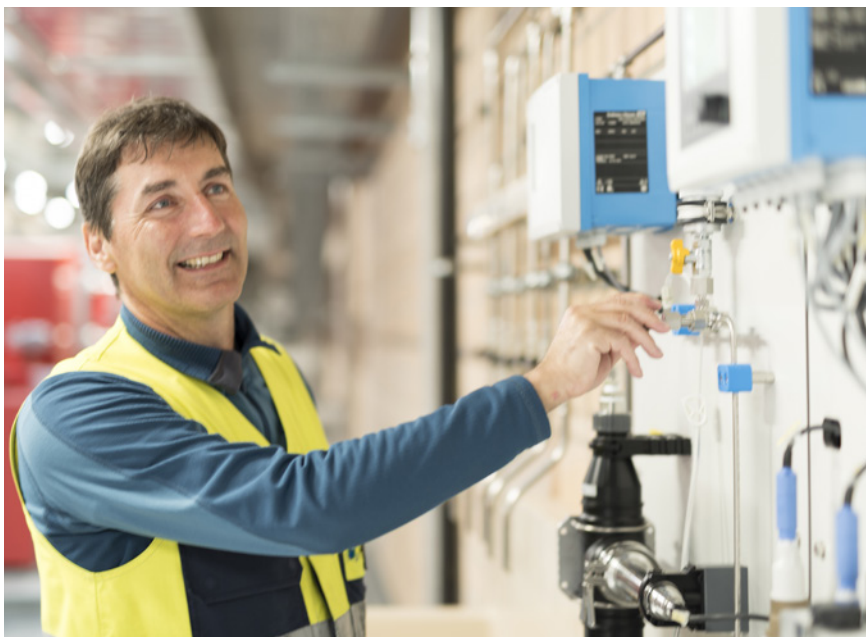
Vandtilsynsføreren på Frasnacht-rensningsanlægget, Rolf Bügler, er yderst tilfreds med analysepanelet fra Endress+Hauser.
