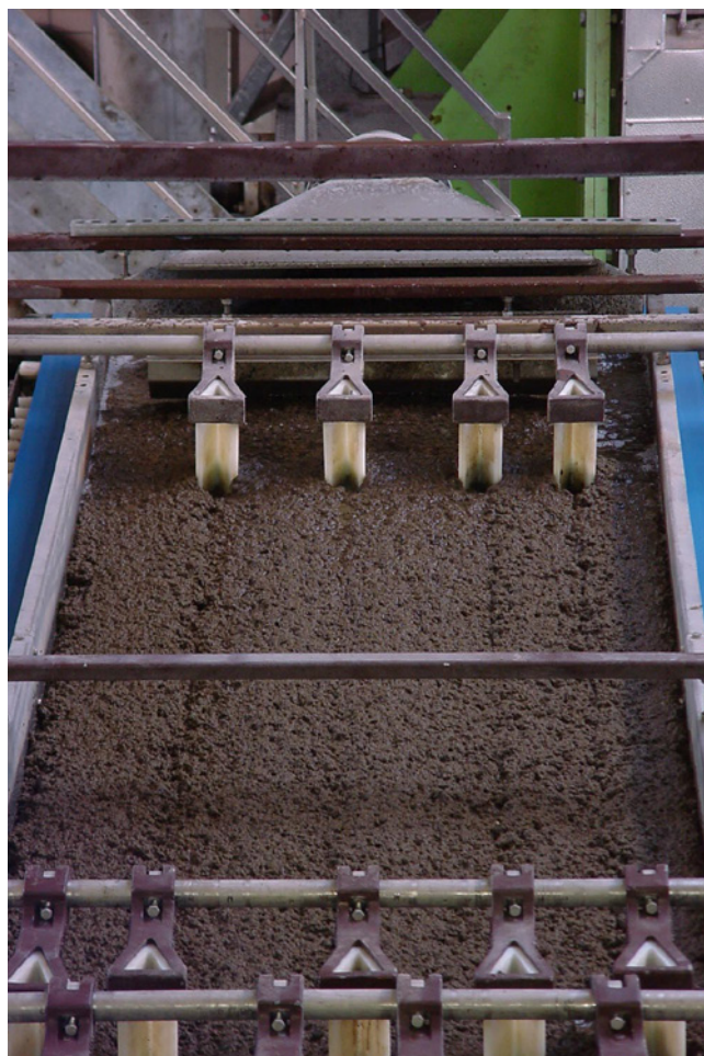
Båndfilter til afvanding af slam fra kommunalt rensningsanlæg.
