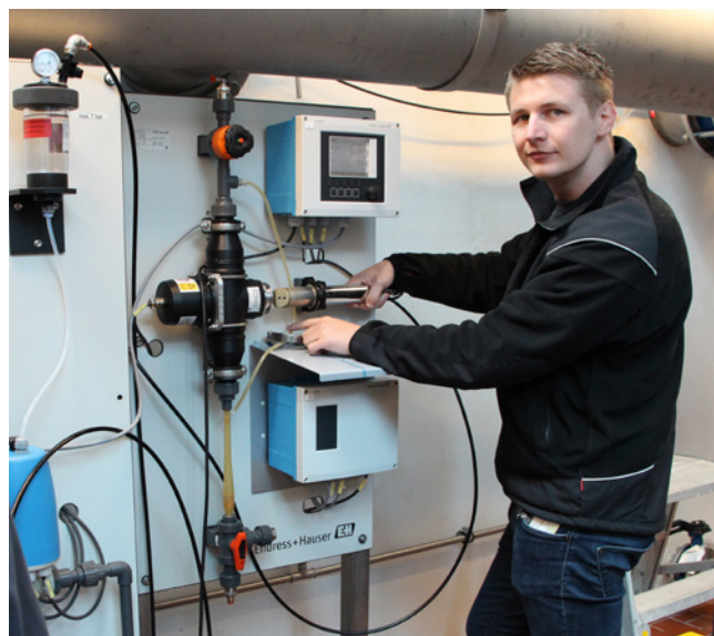
Bo Sværke Bonde med demonteret turbiditets sensor.
