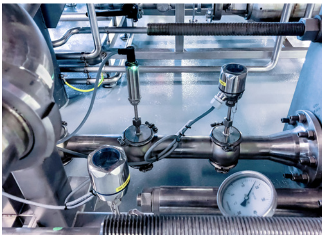
iTHERM TrustSens installeret på bryggeriet.
