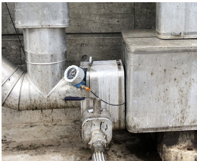
Liquiphant FTL50B installeret som pumpesikring.
