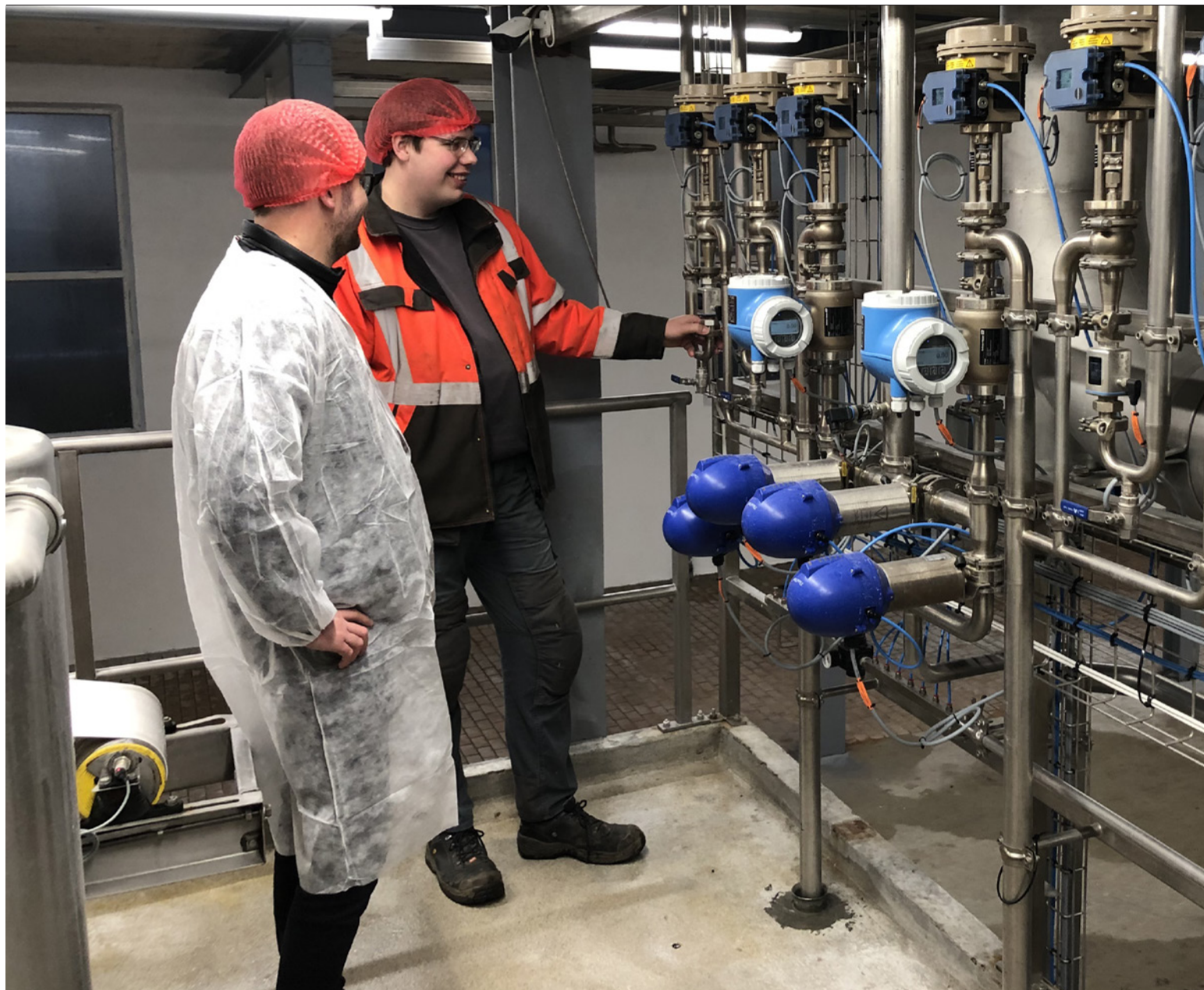
Projekt og udviklingschef ved AKS Toftlund, Kim Puggaard Matzen, fremviser her en flowmåler installation til salgsingeniør Thomas Andersen fra Endress+Hauser. Flowmålerne regulerer tilførslen til vakuumfiltrene.
