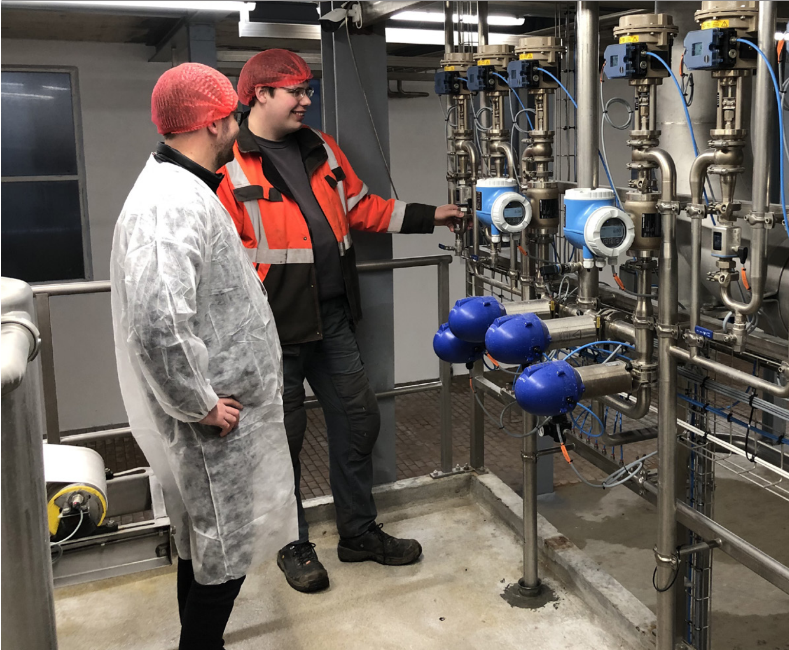
Projekt og udviklingschef ved AKS Toftlund, Kim Puggaard Matzen, fremviser her en flowmåler installation til salgssingeniør Thomas Andersen fra Endress+Hauser. Flowmålerne regulerer tilførslen til vakuumsiltrene.
