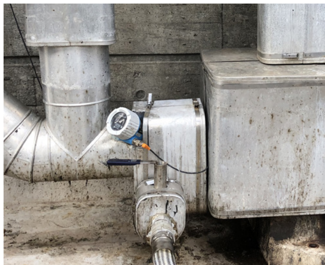
Liquiphant FTL50B installeret som pumpesikring.
