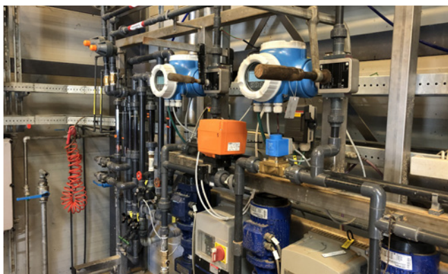
De nye flowmålere Proline Promag H 300 i kemidoseringsen for efterpolering i udløb, hvor polymer oplandes i vand.
