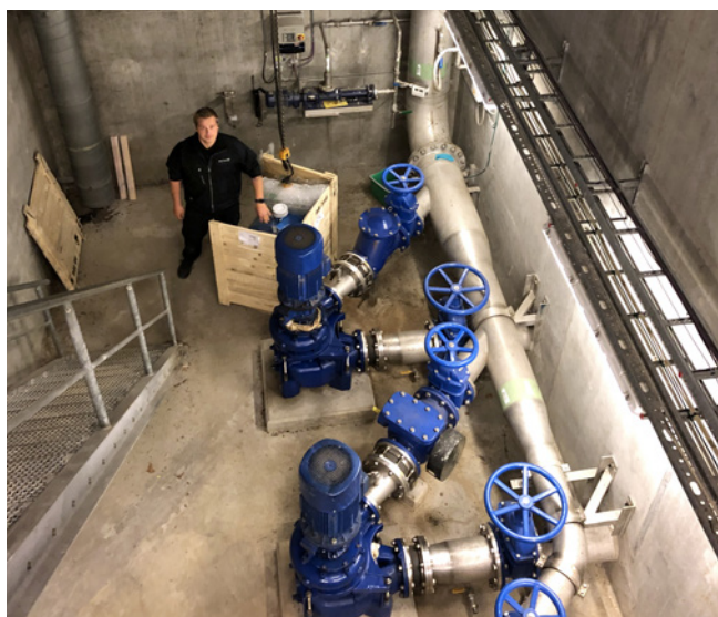
I udløbsstationen er den nye flowmåler Proline Promag W 400 ankommet.
