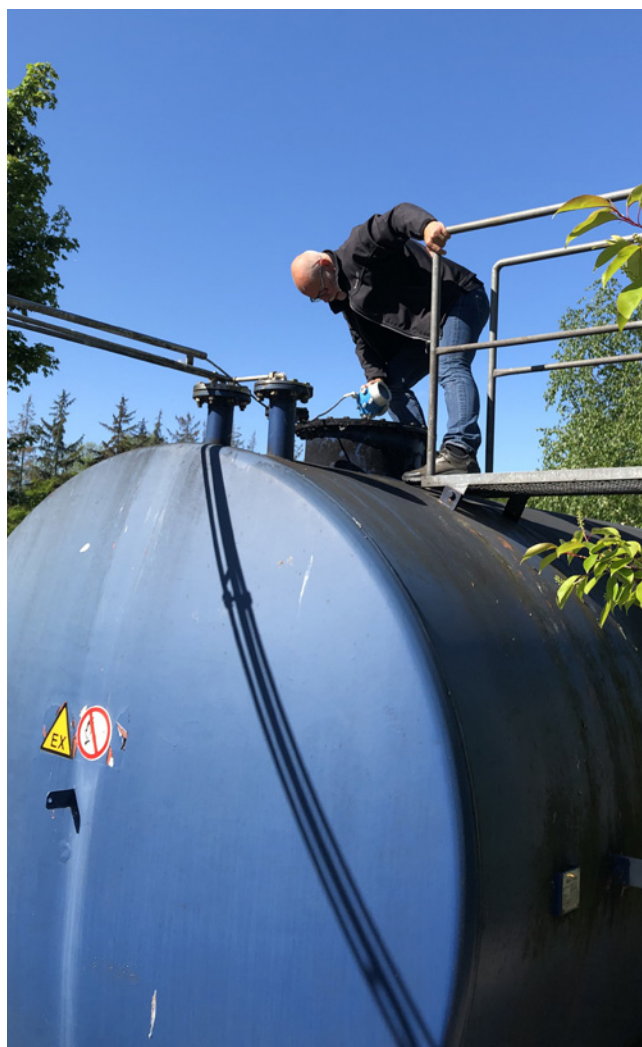
Radarmåleren, Levelflex FMP51, er fastgjort oven på ethanol-tanken.
