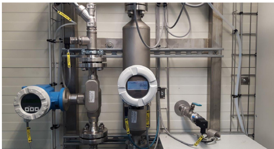
Flowet måles på spildevandet ind, ved destillat ud og koncentrat ud. For at måle flowet på spildevandet anvendes Coriolis flowmåleren, Promass I, der samtidig har den fordel, at den kan måle densiteten på indløbet.
