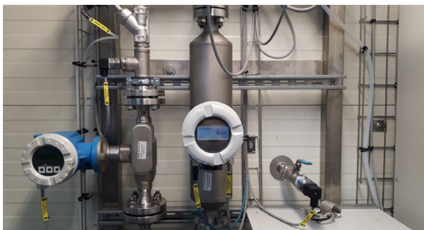
Flowet måles på spildevandet ind, ved destillat ud og koncentrat ud. For at måle flowet på spildevandet anvendes Coriolis flowmåleren, Promass I, der samtidig har den fordel, at den kan måle densiteten på indløbet.
