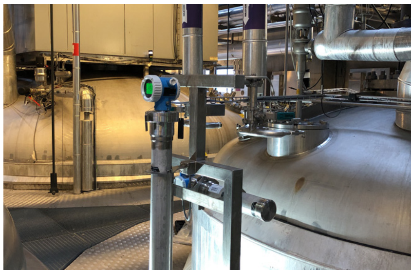
På den nye detektorinstallation er de små kølerørsføringer elimineret.
