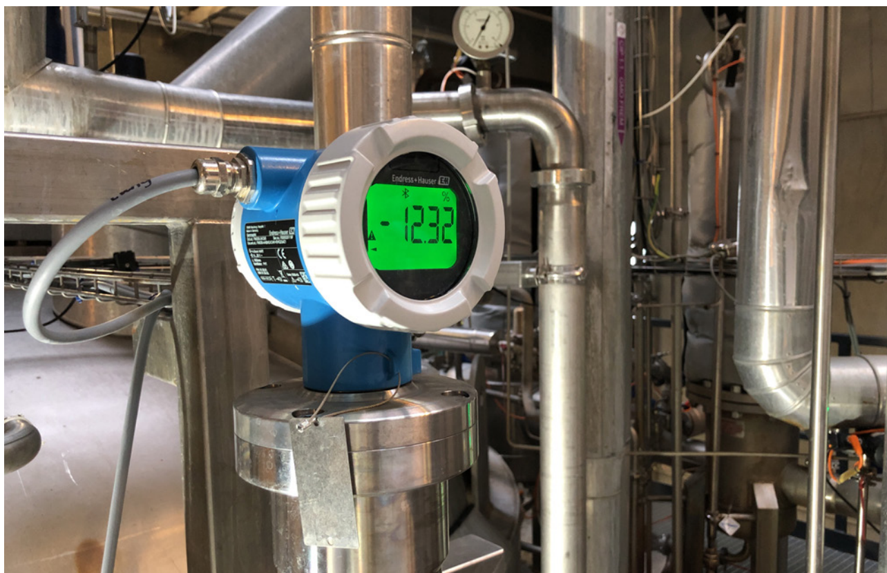
Den nye Gammapiilot FMG50 detektor kan leveres med et letlæseligt og baggrundsbelyst display, som holder dig opdateret på instrumentets status.
