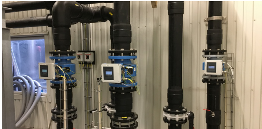
Da installationen er meget kompakt, var det en afgørende fordel, at der ikke skulle tages højde for de normale respektafstande omkring flowmålere.
