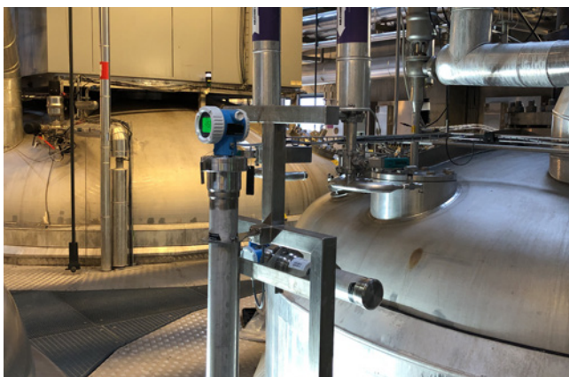
På den nye detektorinstallation er de små kølerørsløbninger elimineret.
