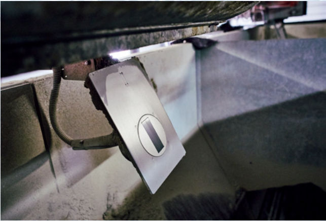
Sten, grus, cement og andre betonkomponenter måles for fugtighedsindhold når de hældes i blanderen.
