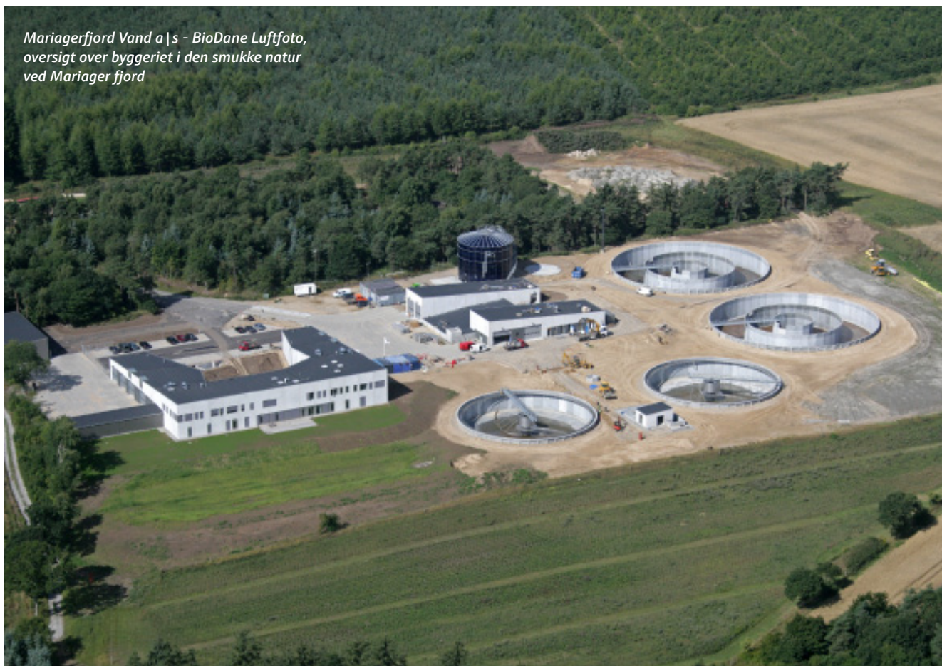
Mariagerfjord Vand a|s - BioDane Luftfoto, oversigt over byggeriet af Mariagerfjords nye rensningsanlæg med driftsbygning, rensningsanlæg og procestankene
